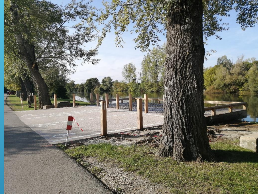
Création d'un ponton PMR
