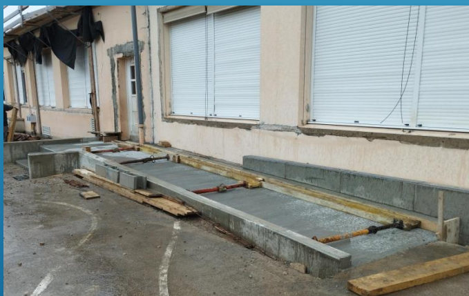
Mise aux normes de la rampe PMR.
