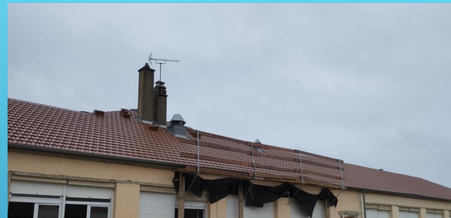
Reprise de la toiture.
