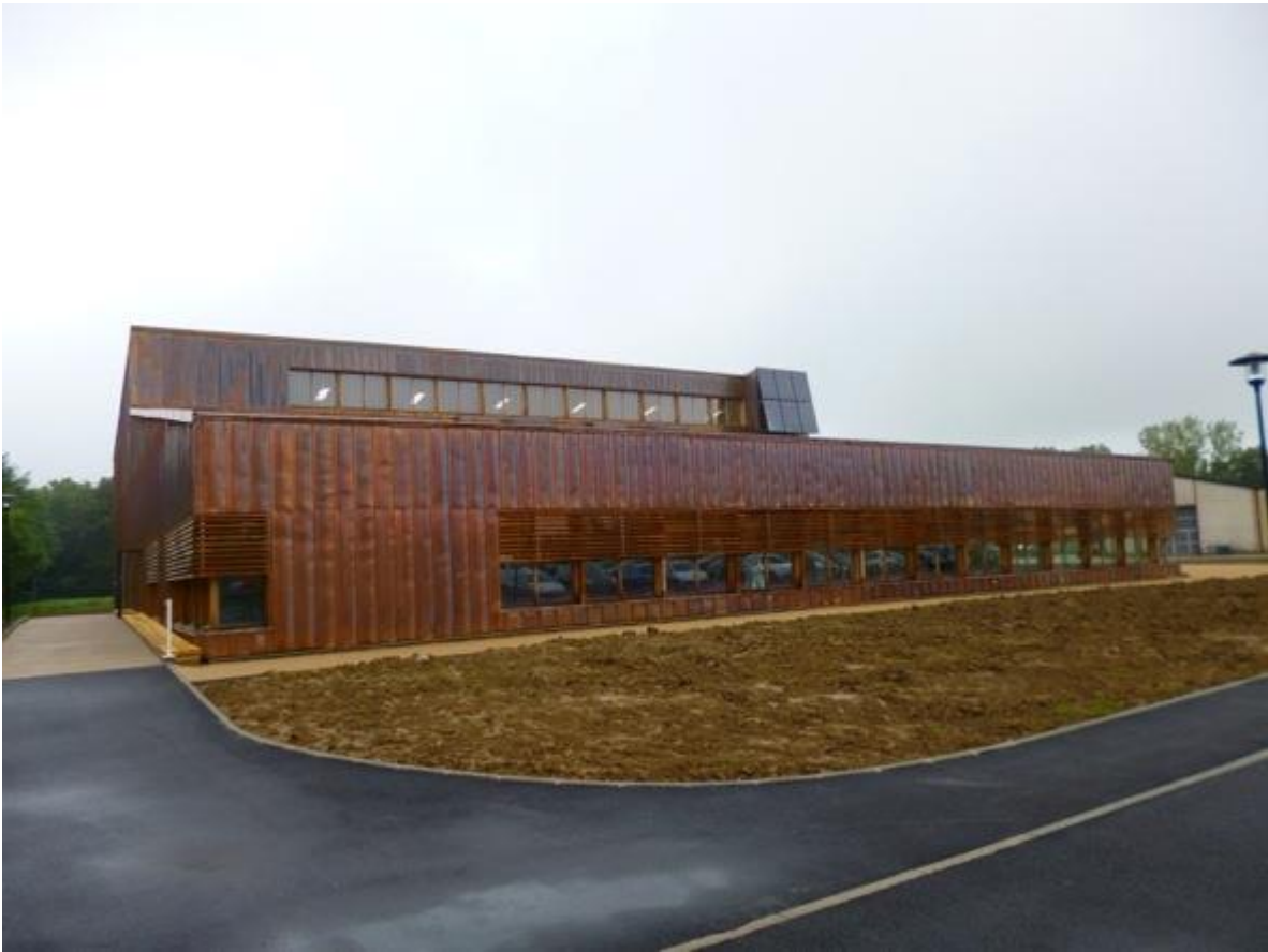
Gymnase salle multi activités : rue des ecoles à CHATEAURENAUD
