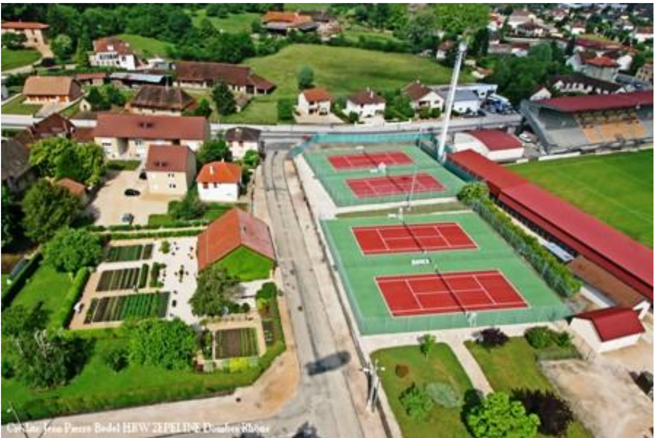
Terrains de tennis : rue de la Chapellerie à LOUHANS
