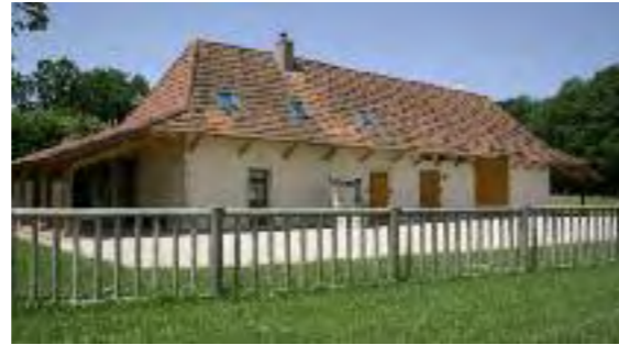
Clôture à piquets et traverses en pin
